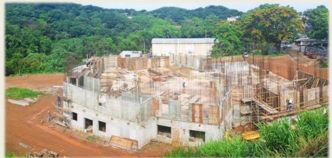
Construcción Iglesia UAA, en proceso desde 11/14
